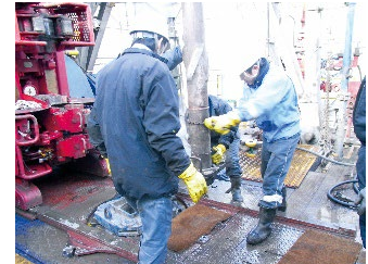
調査井掘削の様子
