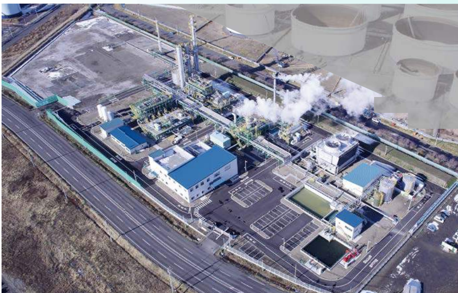
苫小牧CCS実証試験センター プラント全景
