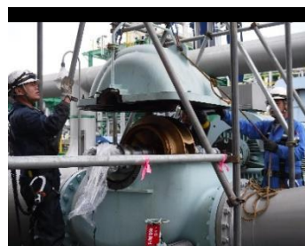
ケーシングカバー取外し
