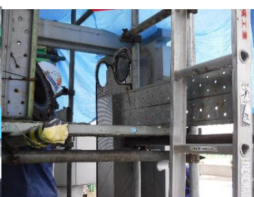
プレート組み立て
