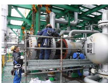
チューブバンドル挿入
