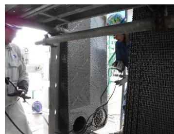
アミン冷却器プレート取外
