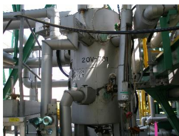
ブローダウンドラム整備後復旧
