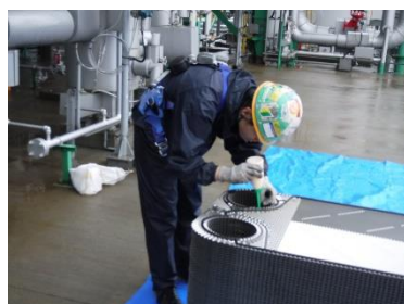
プレートガスケット取付
