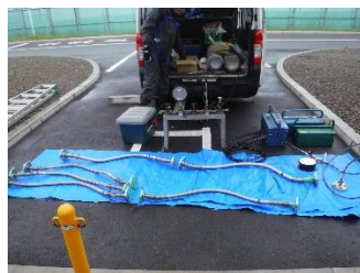
フレキシブルチューブ 耐圧試験準備
