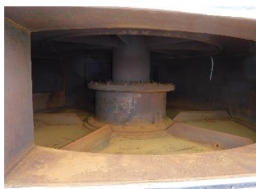
RTO 処理ガス入口部検査
