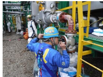
バルブ分解整備
