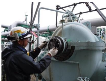
循環冷却水ポンプカップリング取外し
