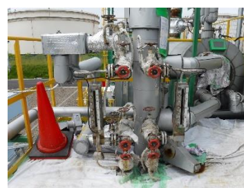
整備後液面計取付
