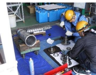
脱水機分解整備
