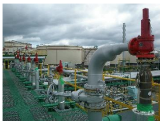
整備後安全弁取付
