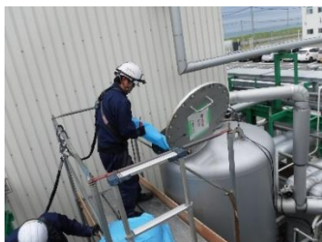
排水処理濾過槽砂交換 水分計点検整備
