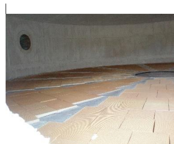
RTO 燃焼室検査
