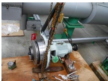
ケーシングカバーとインペラー組立
