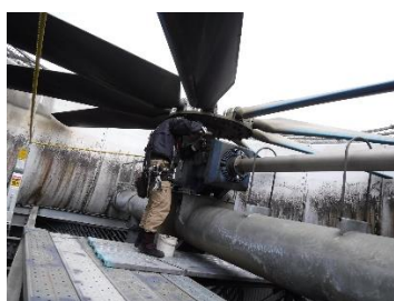
循環冷却冷却塔ファン点検整備
