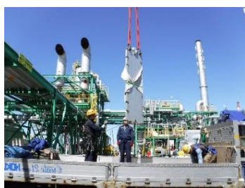
側板トラック積み出し
