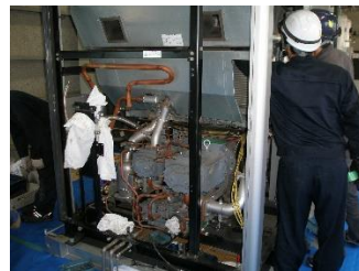
空気圧縮機整備
