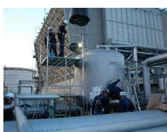
循環冷却サイトフィルタ-充填物交換
