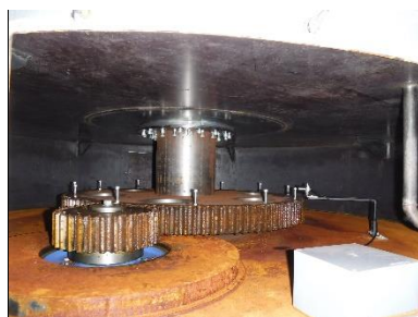
RTO ロータリバルブギア点検
