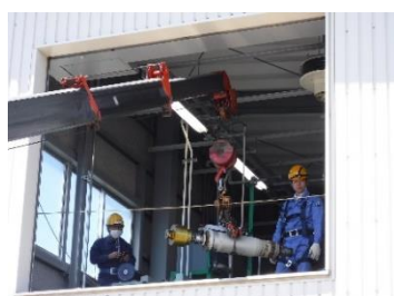
排水処理脱水機持出
