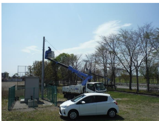
通信線張り替え工事の様子
