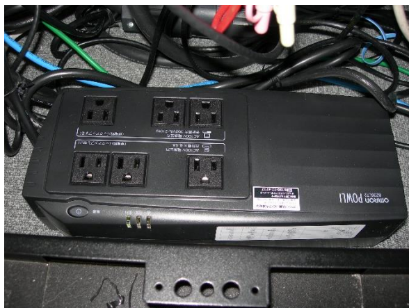
図 4.3-13 ハブ用 UPS の取り付け状況
