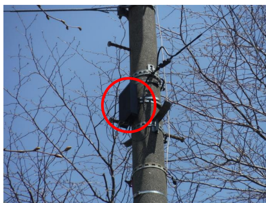
作業終了後の中継BOX
