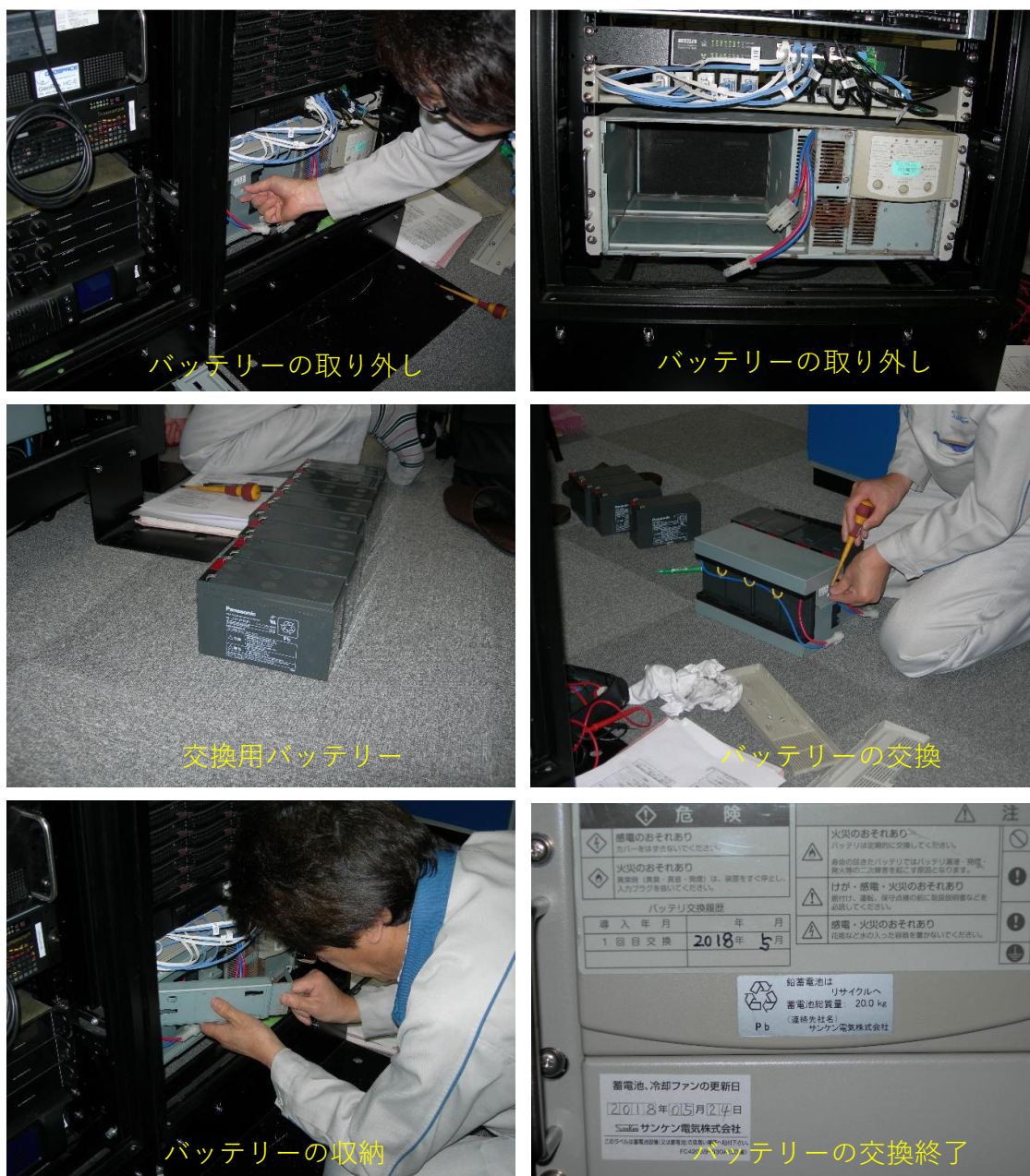
図 4.3-12 サンケンUPS 内蔵バッテリーの交換作業の様子
