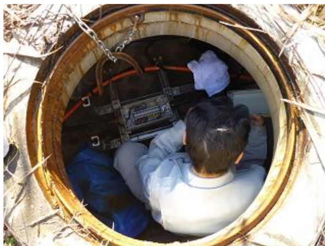
図 4.4-6 ビーチマンホールの中の様子
