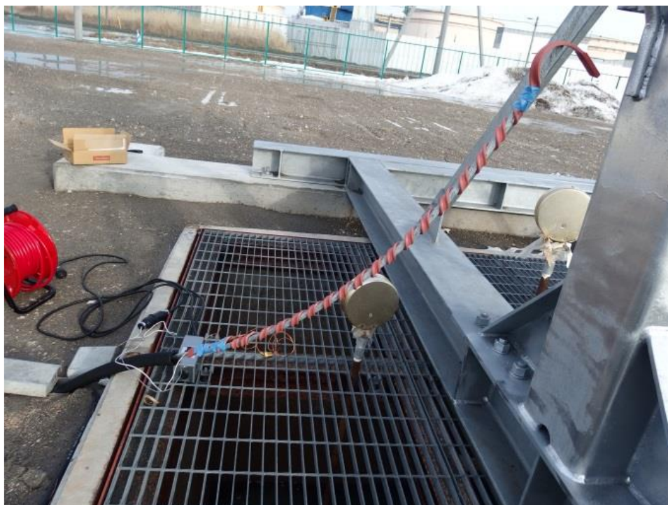
図 4.1-25 リボンヒータによる地表点のアーマードケーブルの昇温の様子
