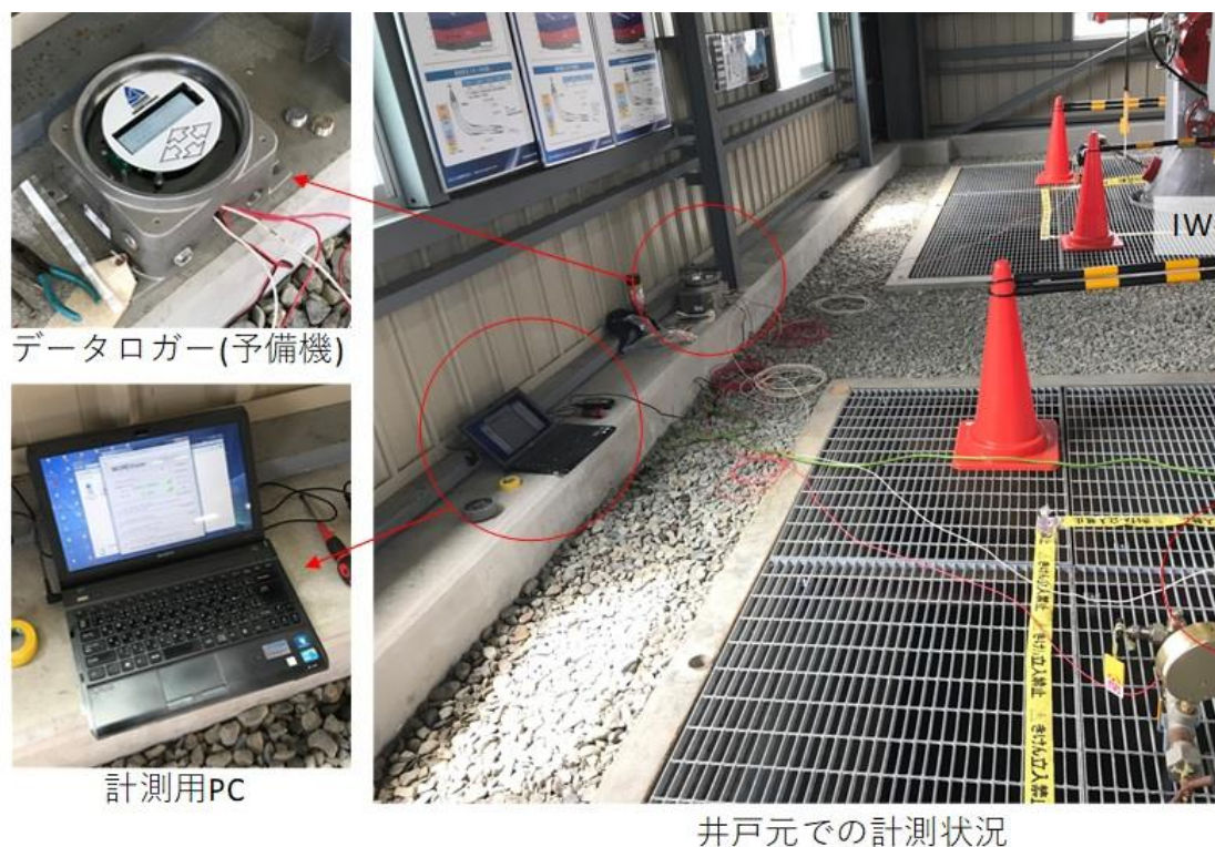
図 4.5-31 圧入井建屋内での作業の様子
