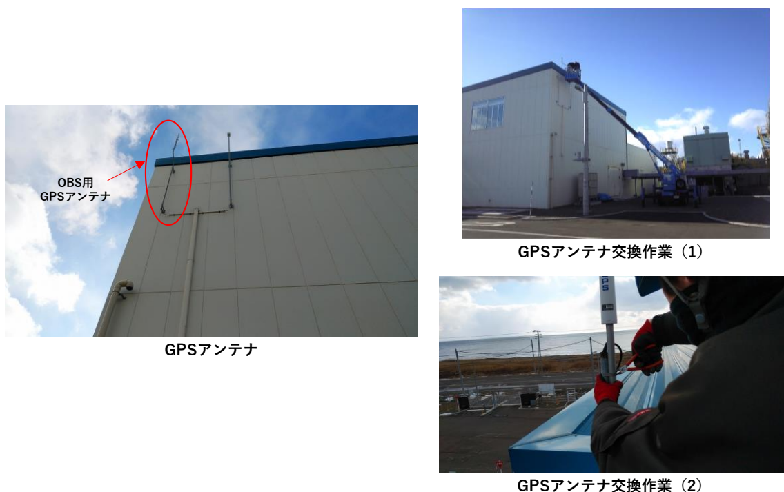
図 4.4-30 GPS アンテナ交換作業の様子
