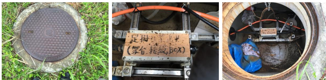
図 4.4-9 ビーチマンホール点検時の様子
