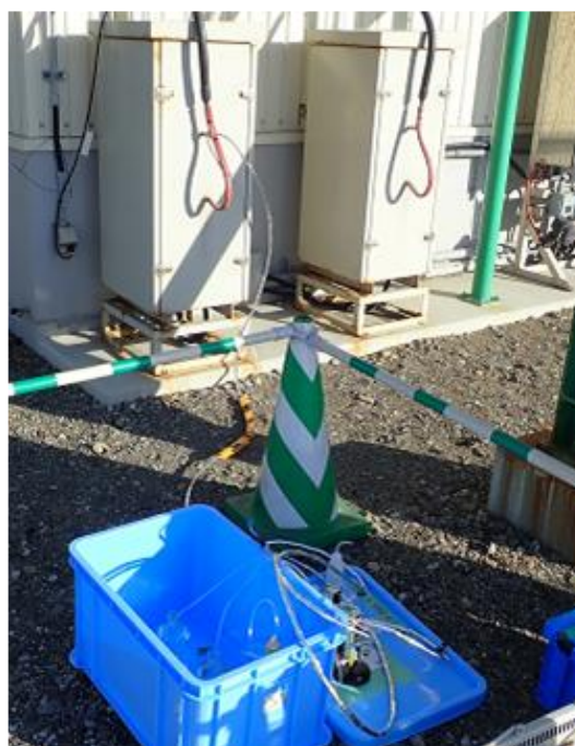
図 6.11-5 現地作業の様子
