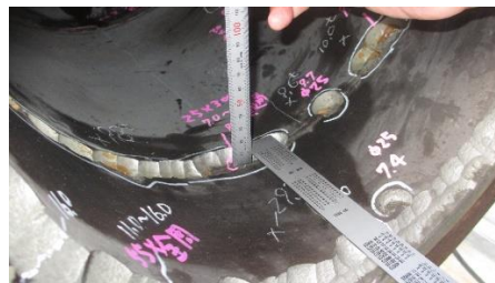
下流レーザー溶接部
