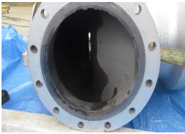
FV-002 下流フランジ全体
