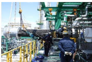
チューブバンドル挿入
