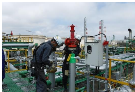
安全弁取外し作業
