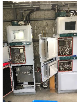
ガスクロ点検整備
