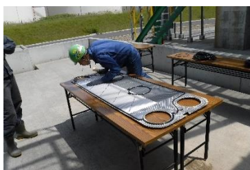
プレートガスケット取付
