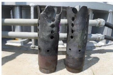
フレア・ロットバーナー取外し
