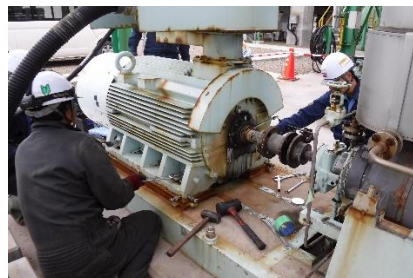
給水ポンプ心出し作業
