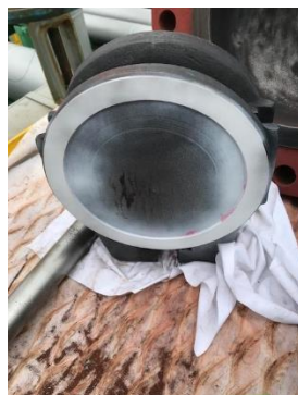
給水仕切弁ディスク検査
