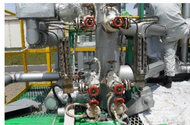
整備後液面計取付
