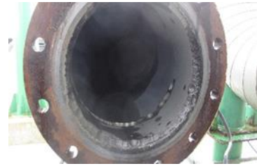
下流フランジ全体
