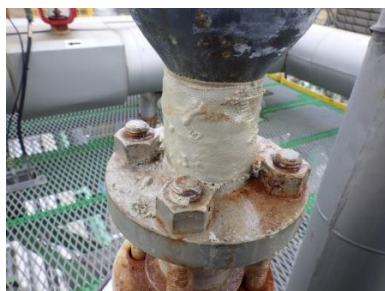
補修テープ施工
