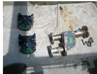
排水給水流量計整備
