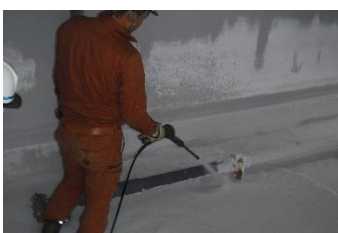
純水中和槽清掃
