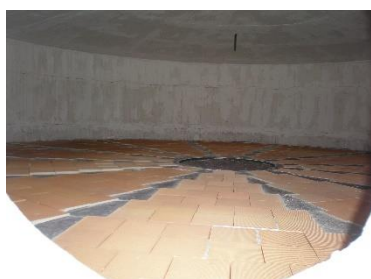
RTO 燃焼炉内部点検
