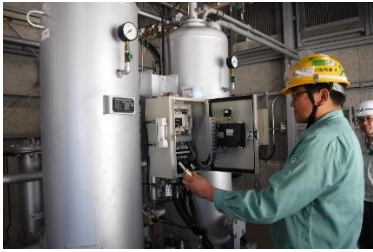
計装空気ドレーヤー点検
