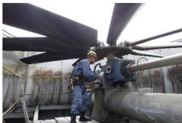
循環冷却塔ファン点検整備
