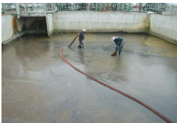
排水処理水槽汚泥回収 脱水機分解整備
