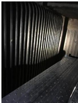
側壁チューブ点検・清掃
