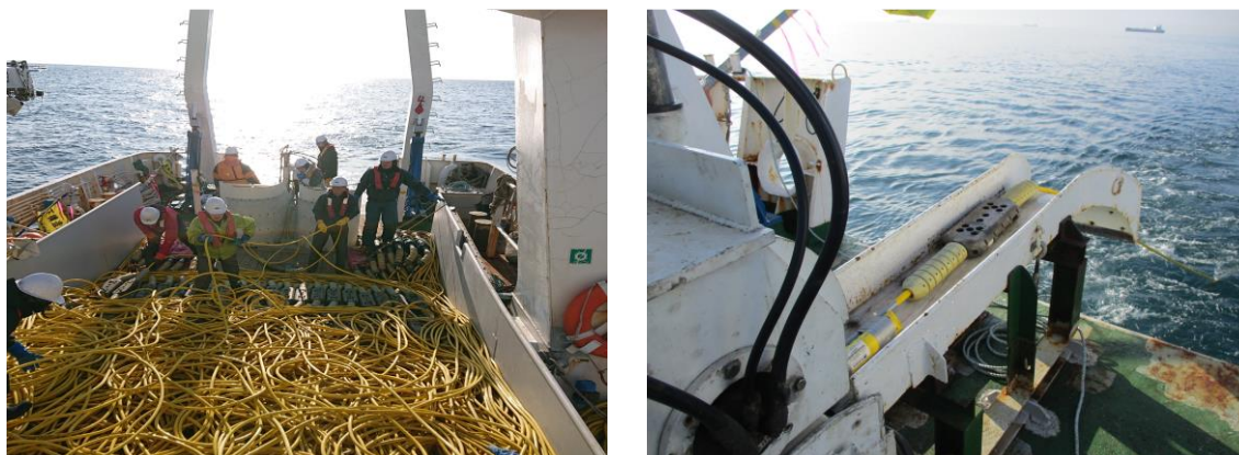
図 4.7-4(3) 現場作業写真（OBC 敷設作業）
