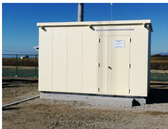
図 4.1-17 観測ハウス（外寸：幅 4.2m×奥行 2.1m×高さ 2.75m）
