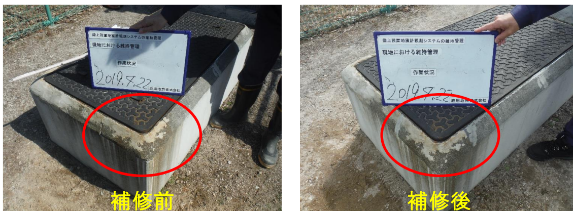
図 4.2-12 現地観測施設のハンドホール化粧モルタルの補修
