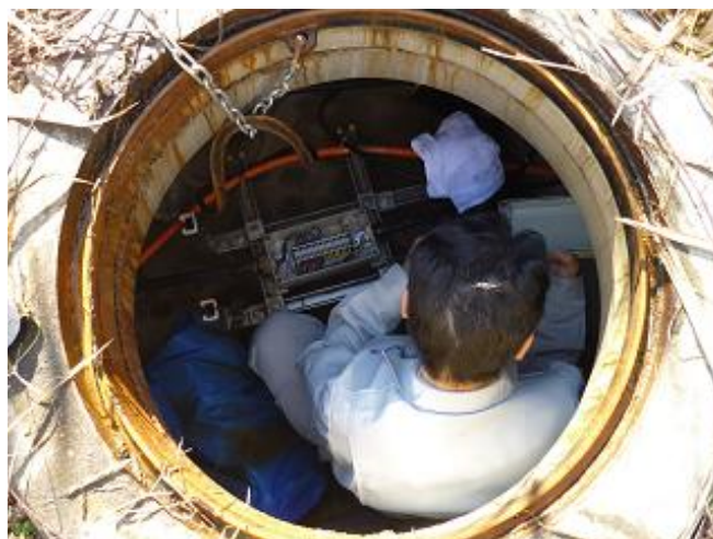
図 4.4-7 ビーチマンホールの中の様子
