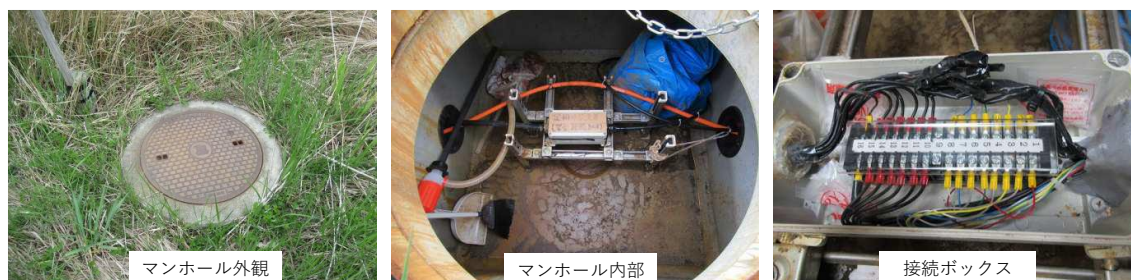
図 4.4-10 ビーチマンホール点検時の様子（5月）
