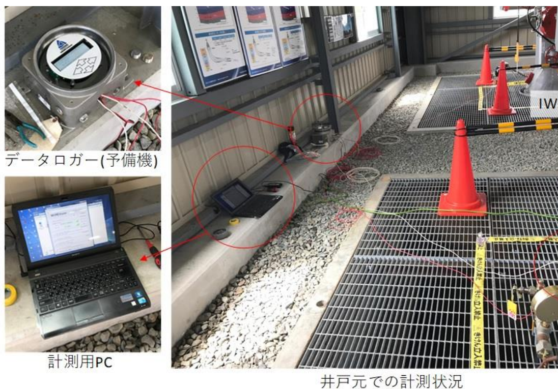
図 4.5-31 圧入井建屋内での作業の様子
