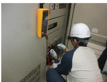
UPS 制御盤確認検査
