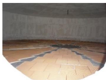
RTO 燃焼炉内部点検
