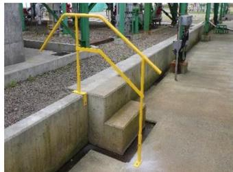
階段転倒危険箇所手摺設置
