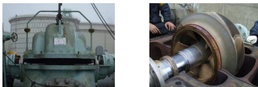
図 2.2-4 (2) 循環冷却水ポンプ分解点検
