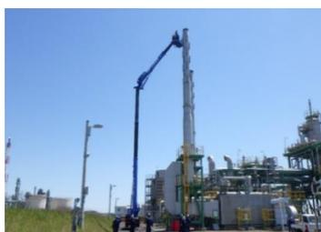
煙突頂上の雨水侵入防止の鉄板養生状況
