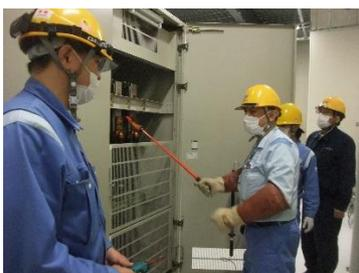
発電設備端子盤電圧検査
