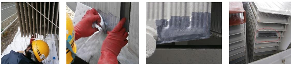
図 2.2-4 (1) 受電変圧器放熱器絶縁油漏洩箇所補修
