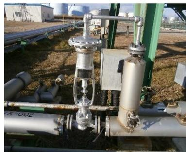
パイロットバーナー燃料ガス自力弁整備
