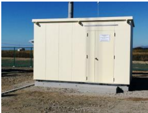
図 4.1-18 観測ハウス（外寸：幅 4.2 m×奥行 2.1 m×高さ 2.75 m）
