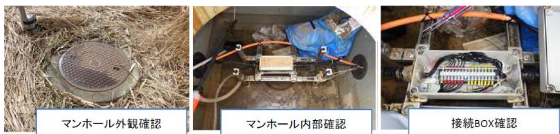
図 4.4-10 ビーチマンホール点検時の様子（2021年2月）
