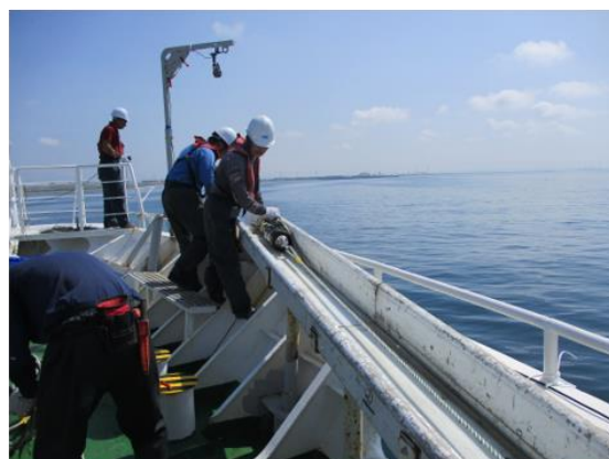
ケーブル揚収作業
