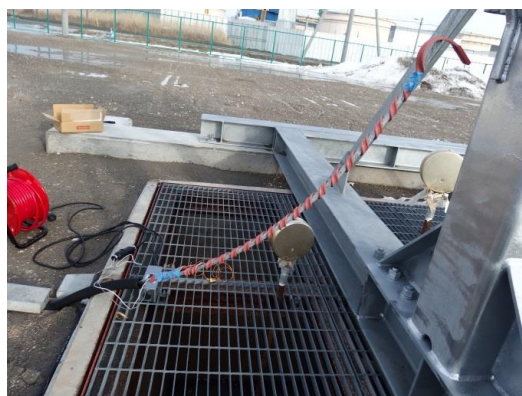
図 4.1-27 リボンヒータによる地表点のアーマードケーブルの昇温の様子
