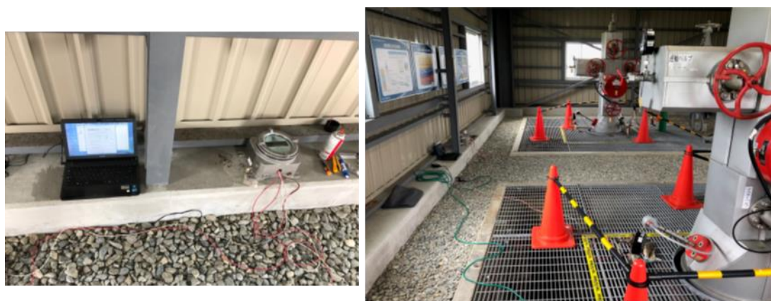
図 4.5-33 圧入井データロガーの点検作業の様子
