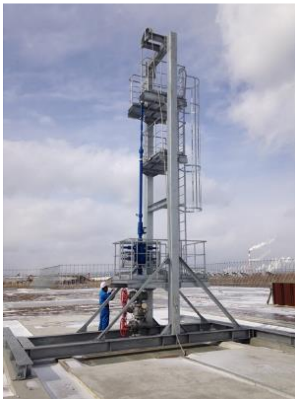
図 4.1-15 OB-1 に設置した坑口装置保持鉄塔および作業用足場
