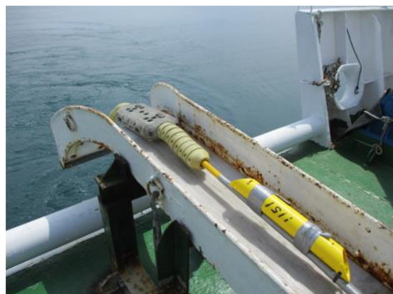
ケーブル敷設作業
