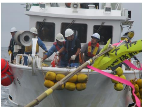
ケーブル引き込み作業
