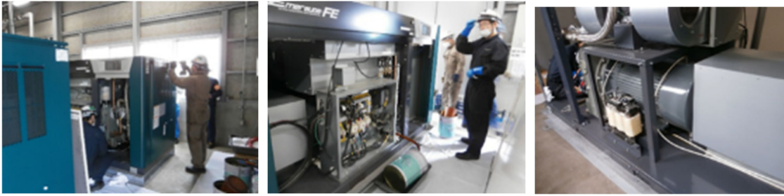
圧縮機カバーの取外し 制御ユニットの点検 計装空気圧縮機電動機の点検
