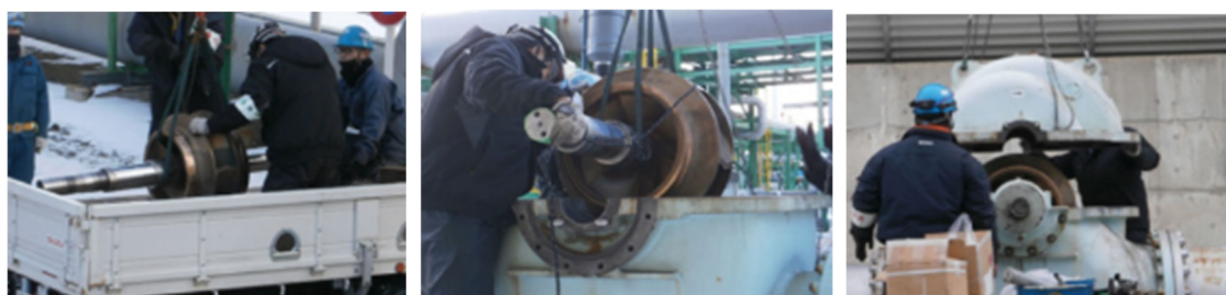
ウェアリング加工済インペラー インペラーの組込み 上部ケーシング復旧
