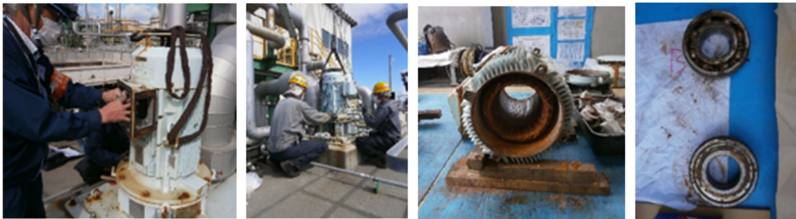
電気ケーブル開線
