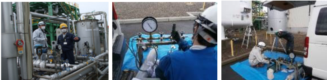
窒素設備設備保安検査
