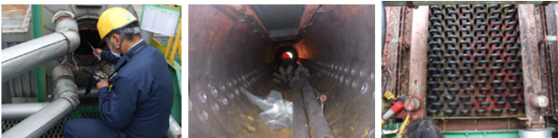
入槽前酸素濃度確認
