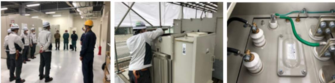
作業前ミーティング 変圧器点検作業 変圧器端子点検
