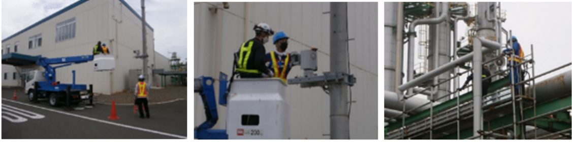
高所作業者による点検
