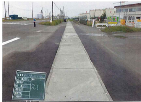
図 2.1-6 修理完了後道路状況
