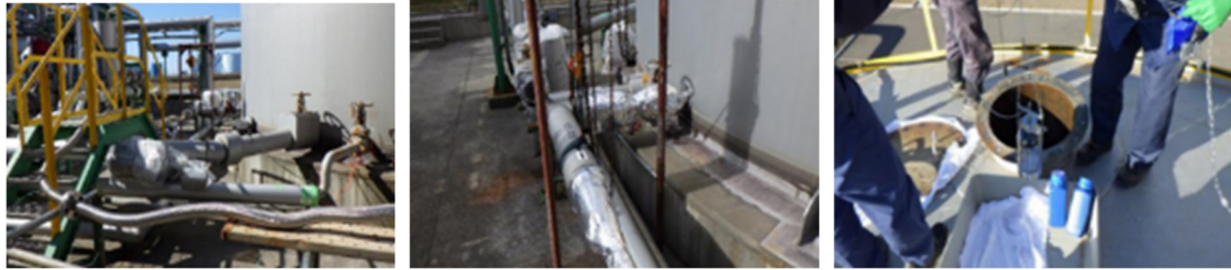
蒸気配管の仮設
