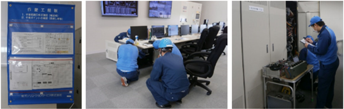
点検作業前 KY 活動板 DCS ハード設備点検(1) 制御室機器の点検(2)
