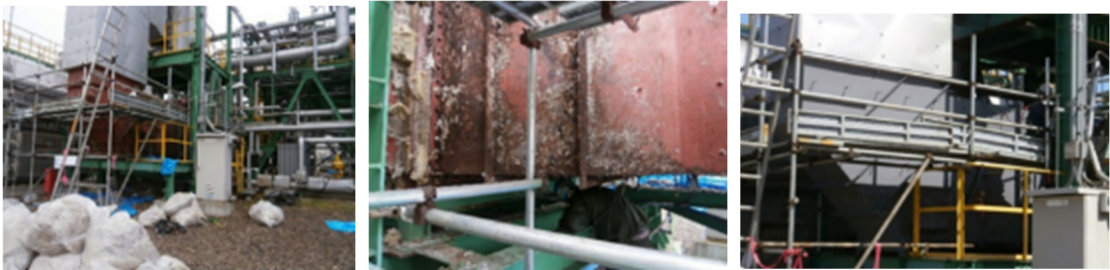
煙道足場架設・保温解体
