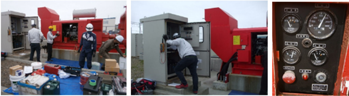
駆動用エンジン点検整備
