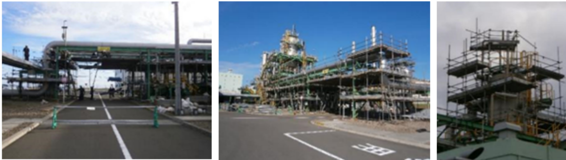
足場架設工事(西側)
