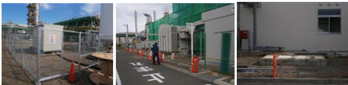
仮設電源設備設置 既設変圧器撤去準備(フェンス撤去) 既設変圧器撤去後の基礎
