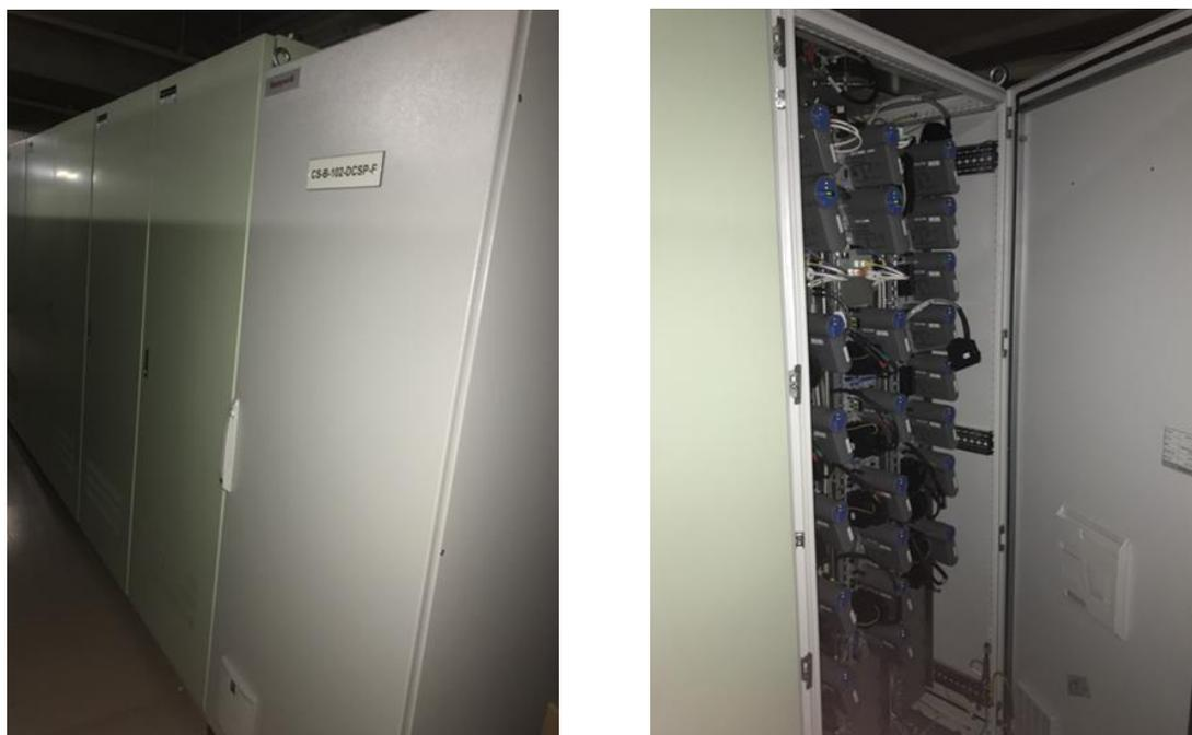
図 1.2-1 現場に設置させた更新DCS装置の外観および内部の様子
