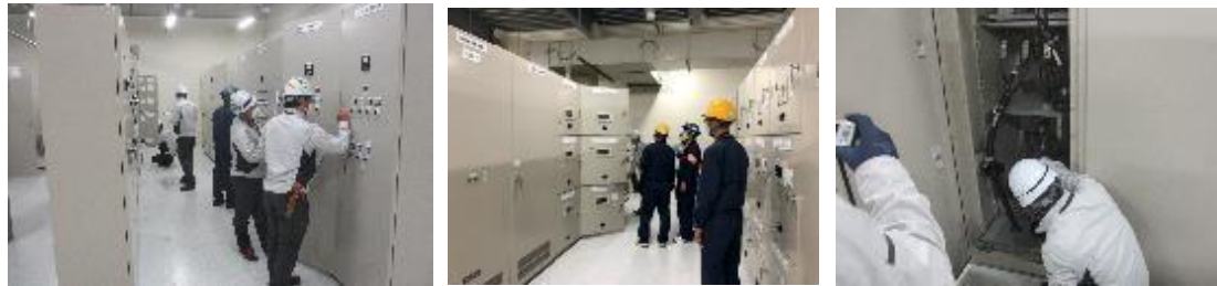
分電盤点検 電気設備点検作業 盤内端子点検
