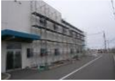
周囲足場架設(東面)
