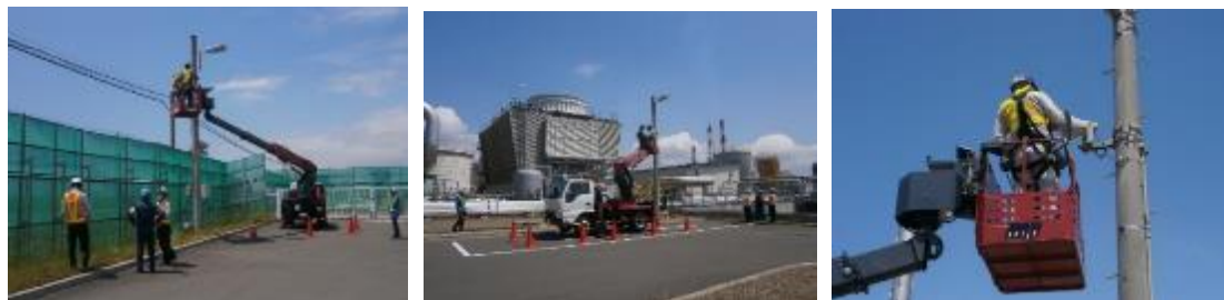
高所作業車で点検整備 同左 スピーカー点検作業
