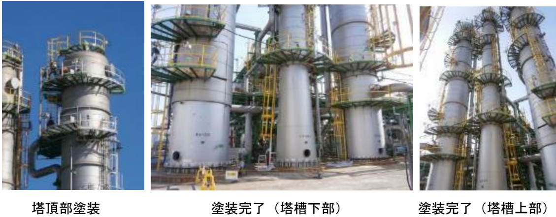
図 2.2-6 (1) 分離回収設備塔槽ラダー・プラットフォーム補修
