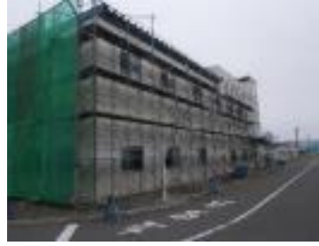
防護ネット設置
