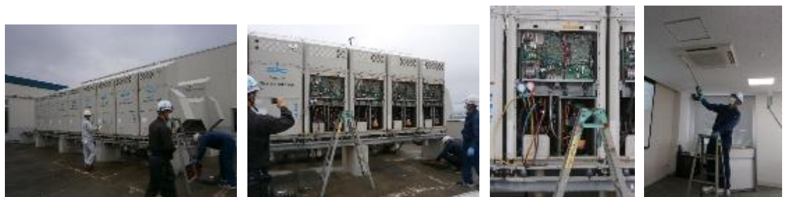
室外機点検準備
