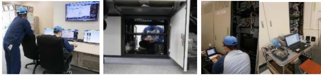
インターフェース点検 機器取外し清掃整備 制御機器点検
