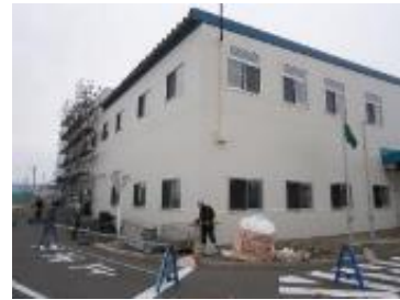
塗装完了仮設足場解体撤去
