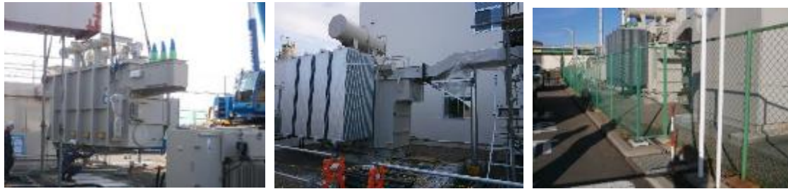
新変圧器据付け作業
