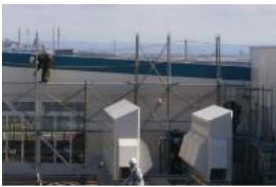
屋上部外壁塗装
