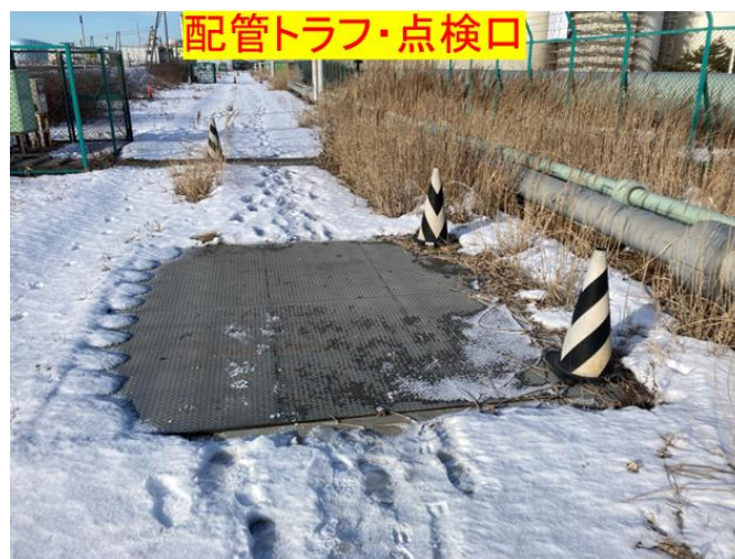
図 2.1-3 除雪作業状況 その3
