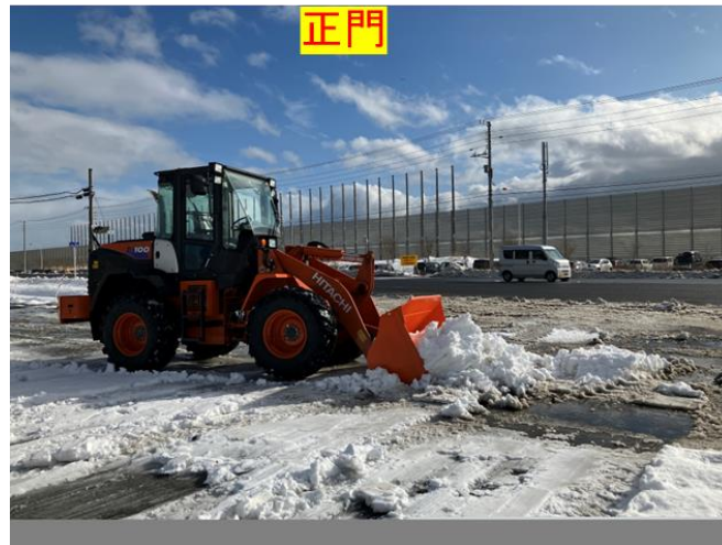
図 2.1-1 除雪作業状況 その1
