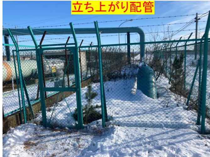
図 2.1-4 除雪作業状況 その4
