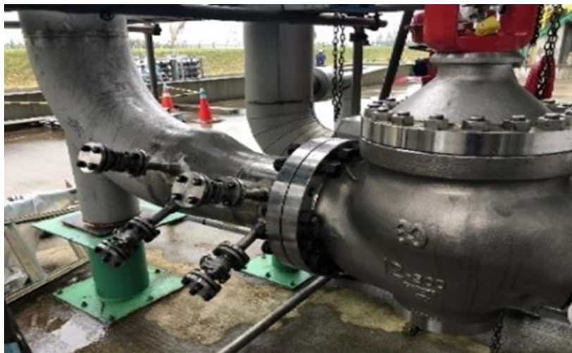
図 2.5-2 腐食センサー取付け治具の状況
