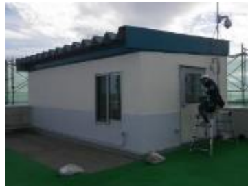
屋上階段室外壁および扉塗装
